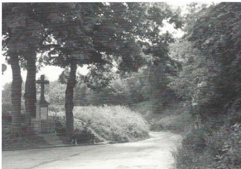
Eine Kreuzanlage an der Salmanusstraße (vormals Grüner Weg) befindet sich an dem Platz der alten Salmanuskapelle.
